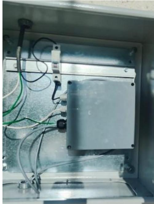
En el módulo transductor podemos encontrar varios conectores, los cuales se utilizarán dependiendo de los elementos que se vayan a instalar en los contenedores, esto nos permite identificar más fácilmente que cables corresponden a la alimentación y cuales a la comunicación.
