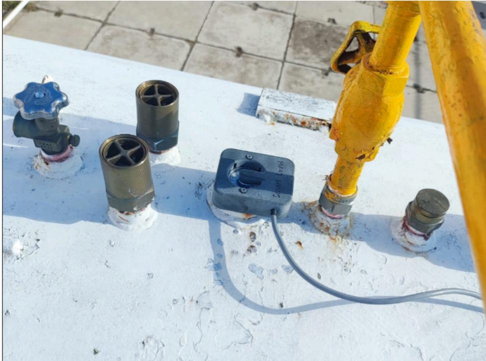
Como se observa en la imagen de la carátula, de esta sale un cable, el cual es el que se encarga de comunicar con el transductor, dicho cable se conecta en el conector con el nombre de "Tank Level"
