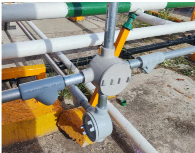
Como se comentó antes, el cable de los colores verde, blanco, amarillo y café, corresponden al cable que viene del concentrador. De esta forma nos permite mantener en comunicación todos los transductores que conforman el almacén con un solo concentrador.
